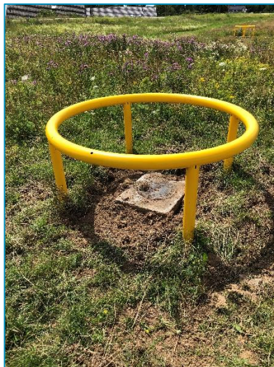
Vrij gegraven put thv gasleiding
