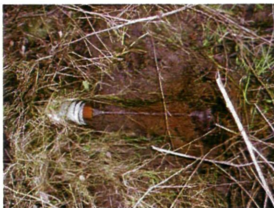
Foto 3: Uitstroomopening hemelwater
