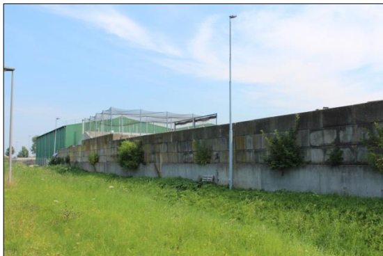
Foto 7 Muur van betonblokken naast milieustraat (2)
