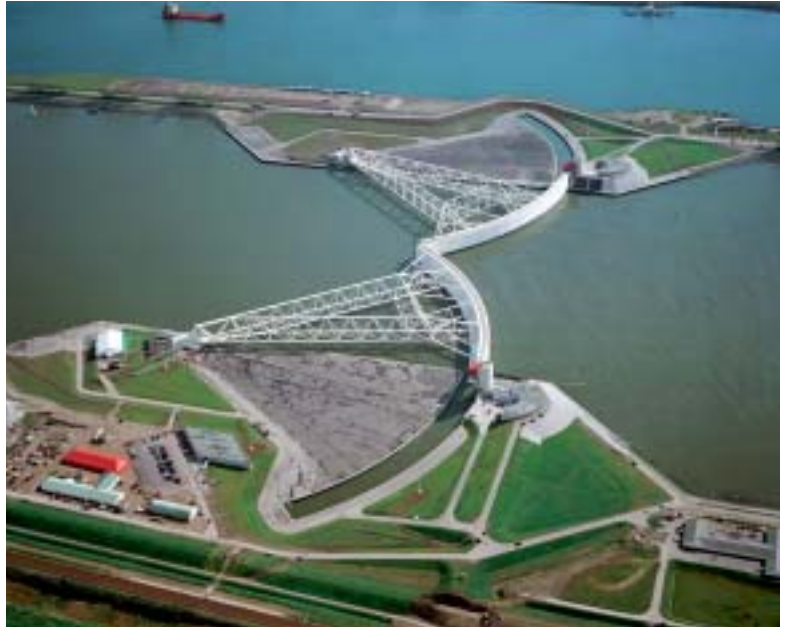
Foto 3.2 Groot waterkerend kunstwerk: de Maeslantkering in de Nieuwe Waterweg (foto MD)
