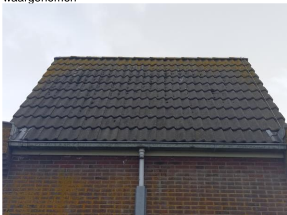
Dakbeschot van hout voorzien van dakpannen
