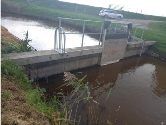
Sluis met kunststof plaat
