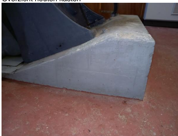
Opstort in gemaal niet asbestverdacht
