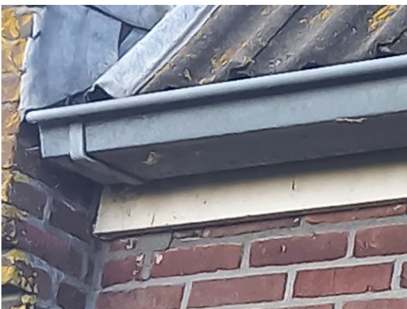
Onderzijde metalen dakgoot voorzien van houten beplating
