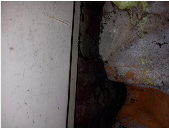
Destructief onderzoek spouwmuur langs kozijn geen asbestverdachte materialen waargenomen
