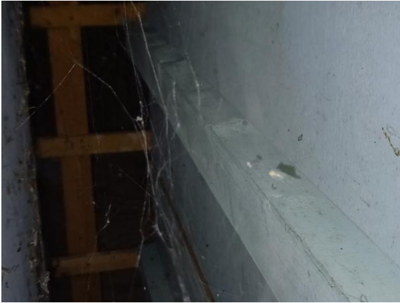
Destructief onderzoek houten betimmering plafond geen asbestverdachte materialen waargenomen
