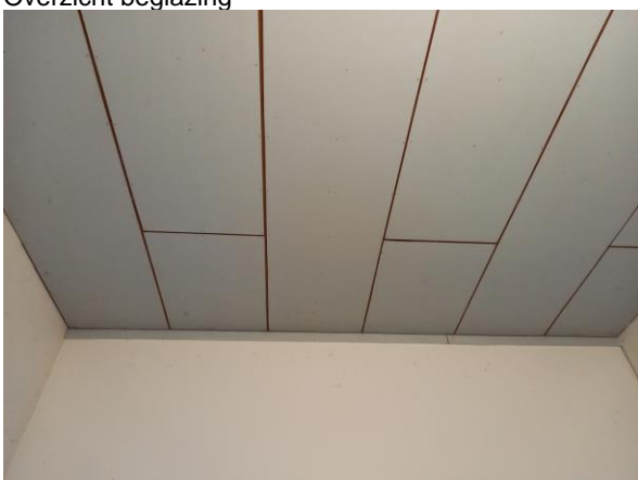
Overzicht houten aftimmering op plafond
