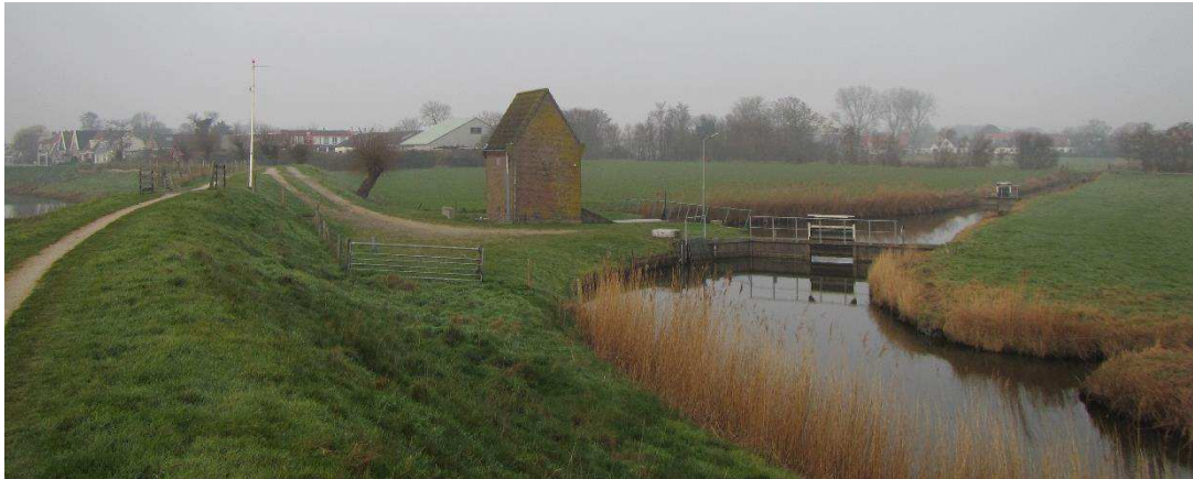
Afbeelding 2 Impressie plangebied genomen vanaf de oostkant van het gemaal.
