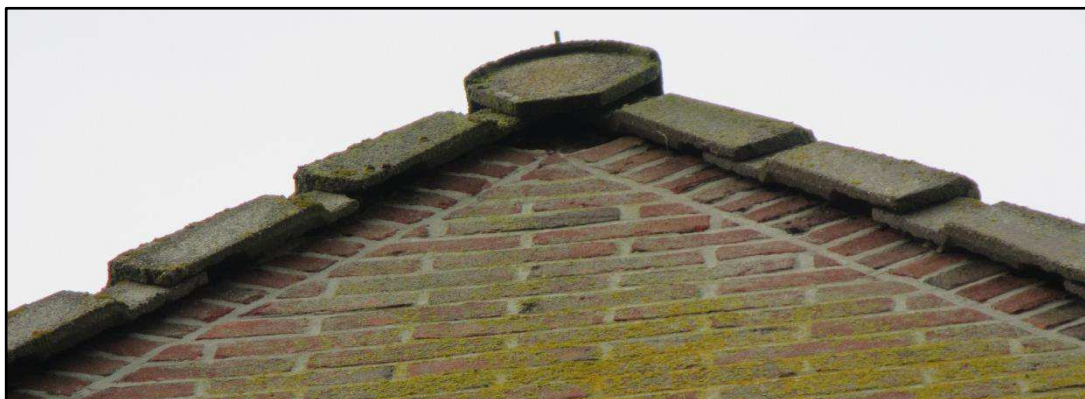
Afbeelding 9 Geschikte invliegopeningen tussen dakpannen.
