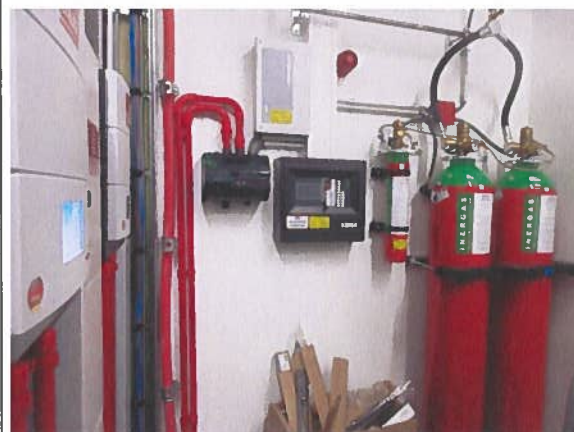
Gasblusinstallatie serverruimte
