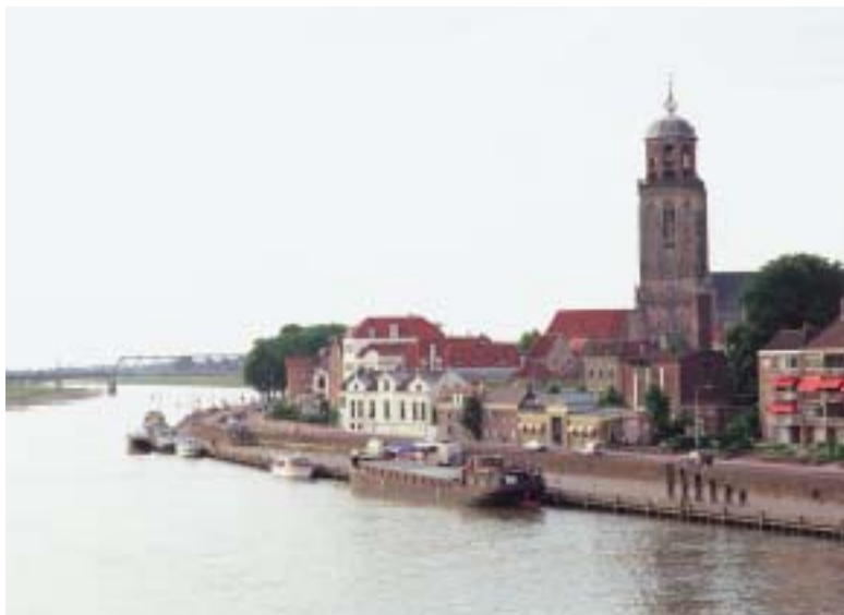
Foto 2.2 Bijzondere constructie: de kade langs de IJssel in Deventer (foto MD)
