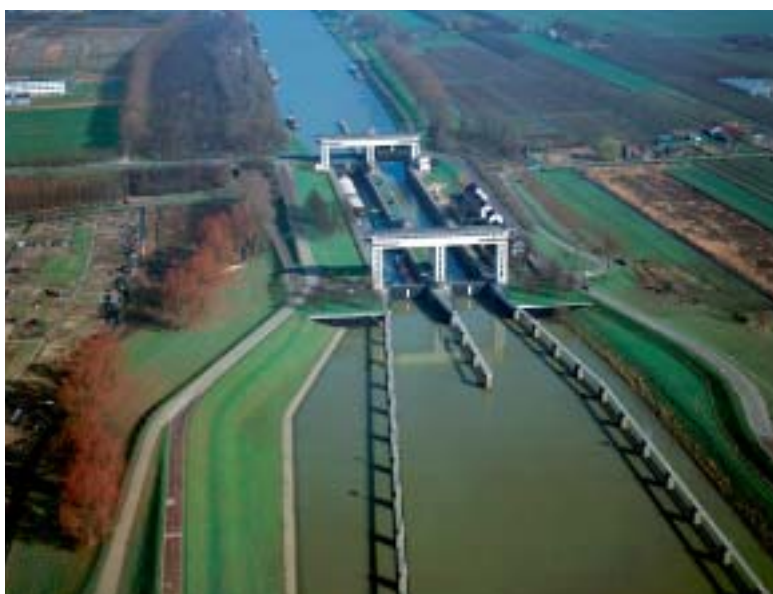
Foto 2.1 Waterkerend kunstwerk: Prinses Beatrixsluizen (Lekkanaal) (foto MD)
