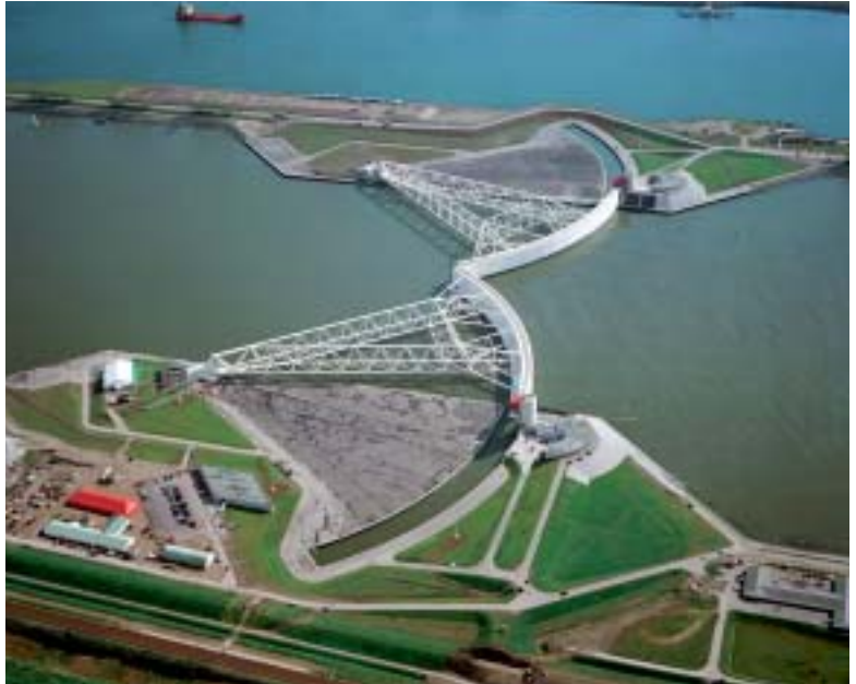
Foto 3.2 Groot waterkerend kunstwerk: de Maeslantkering in de Nieuwe Waterweg (foto MD)
