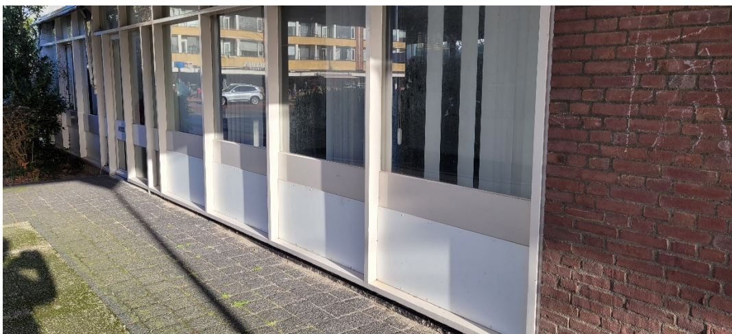
Foto 1: Zicht op de niet asbestverdachte gevelbeplating.
