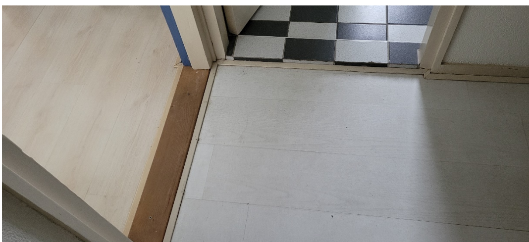
Foto 8: Zicht op de niet onderzochte vloerafwerking op de eerste etage van nummer 80 (zie beperkingen in § 4.3).
