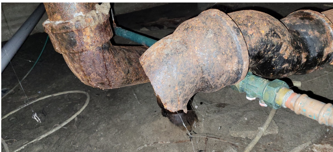
Foto 4: Zicht op de gietijzeren riolering onder de keuken (zie beperkingen in § 4.3).
