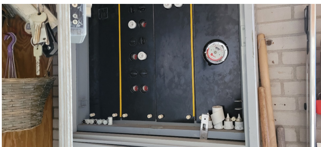
Foto 8: Zicht op de stoppenkast in de berging, zonder asbestverdachte toepassingen.
