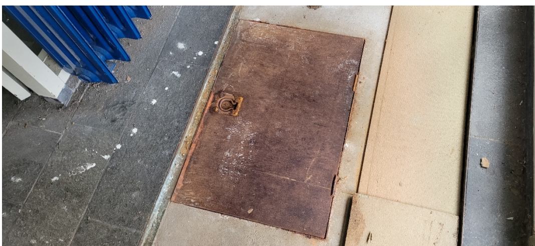
Foto 3: Zicht op één van de kruipluiken in de algemene ruimtes.
