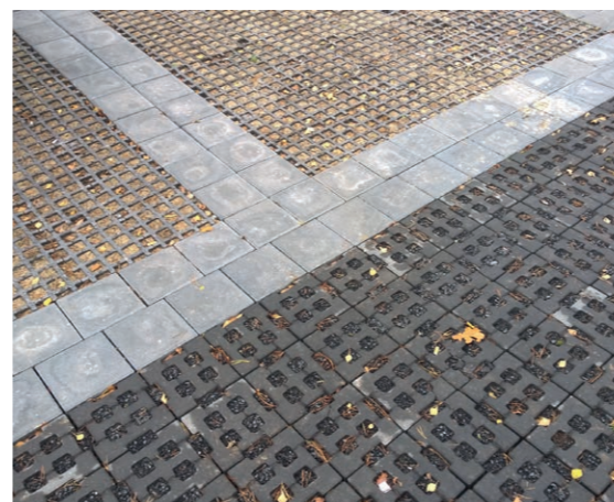
centrale goot en waterdoorlatende verharding
