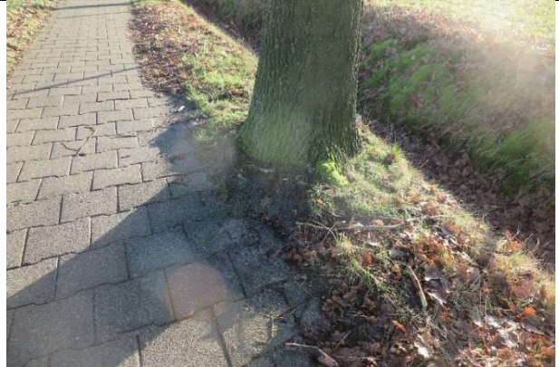
Boom 61 staat op zeer korte afstand van het fietspad
