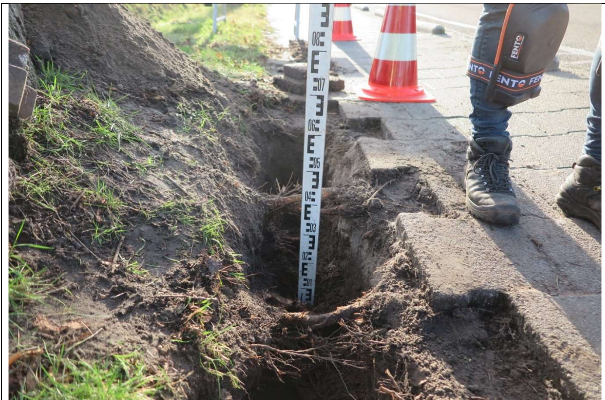
Diepte van de laagspanningskabel (en profielsleuf) ca. 0,4 m
