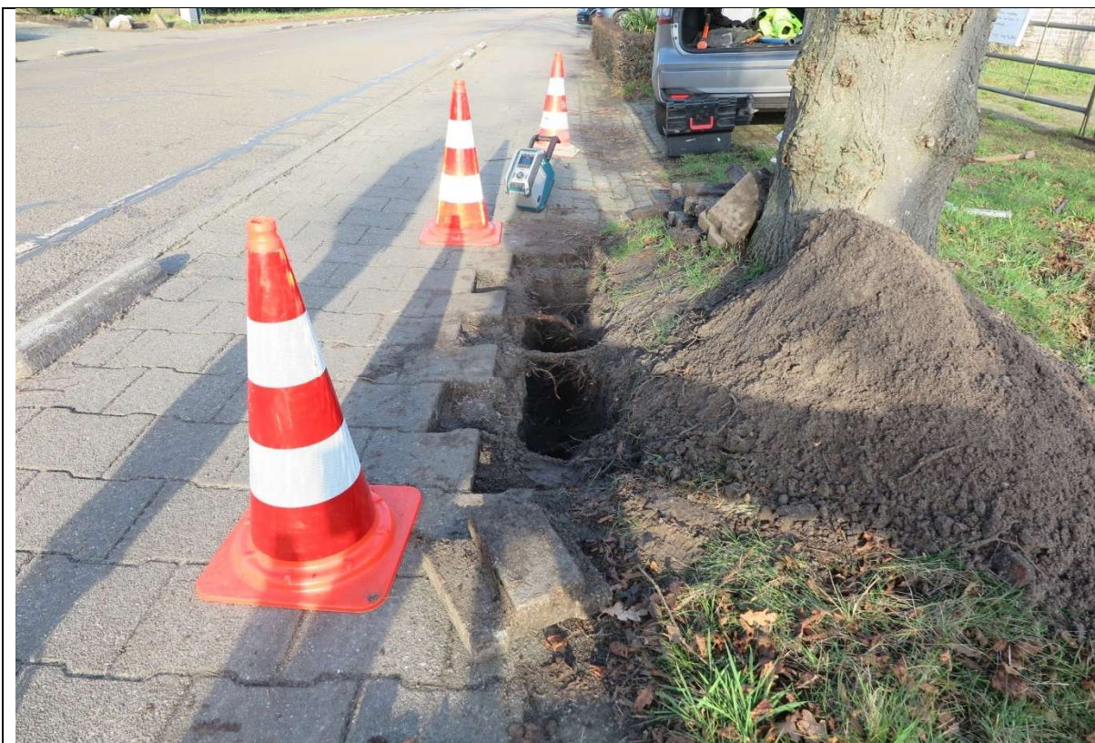
Beeld van de locatie van de profielsleuf op ca. 1 m uit het hart van de boom
