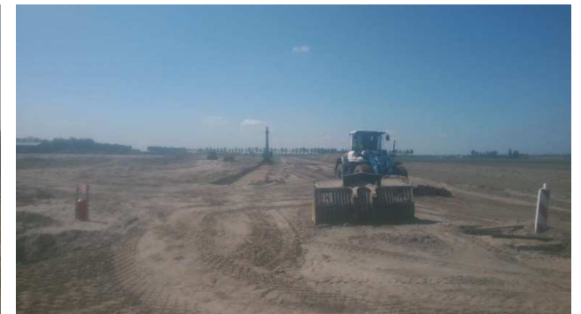
Foto 6: Voorbelasting is uitgevlakt op het terrein
