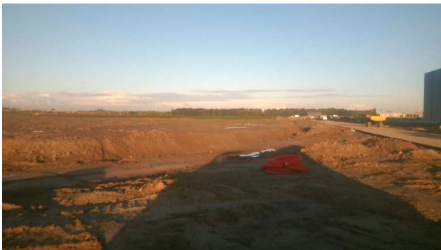
Foto 4: Voorbelasting richting het oosten
