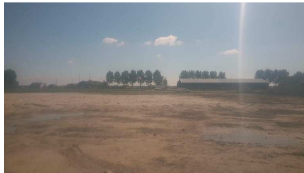
Foto 5: Voorbelasting is uitgevlakt op het terrein
