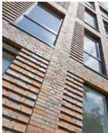
Detail in metselwerk
