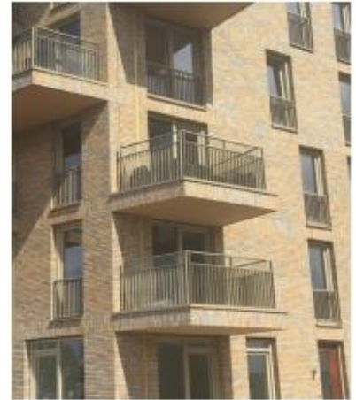
Kozijn in kleurtoon metselwerk
