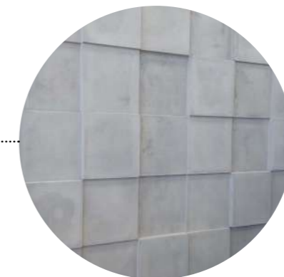
Betonnen gevel relief vlakverdeling in 1x1m
