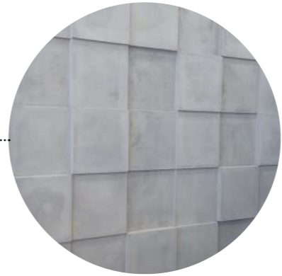
Betonnen gevel relief vlakverdeling in 1x1m
