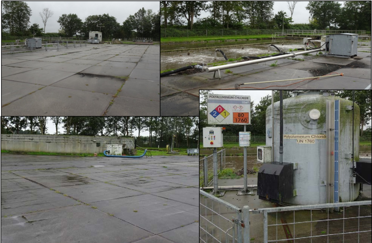
Figuur 4: Foto's terreinverkenning RWZI te Marum
