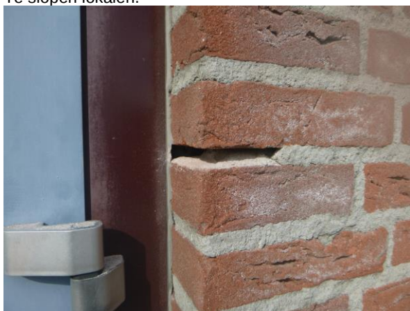
Geen asbestverdachte vochtkeringen in de spouw.
