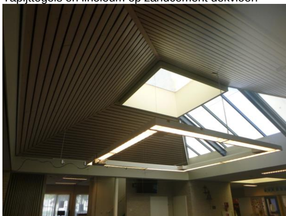
Lichtkoepels en afwerking binnenkant dak.
