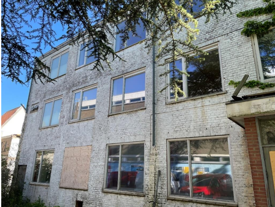
Overzicht achterste en vorste deel zuidgevel
