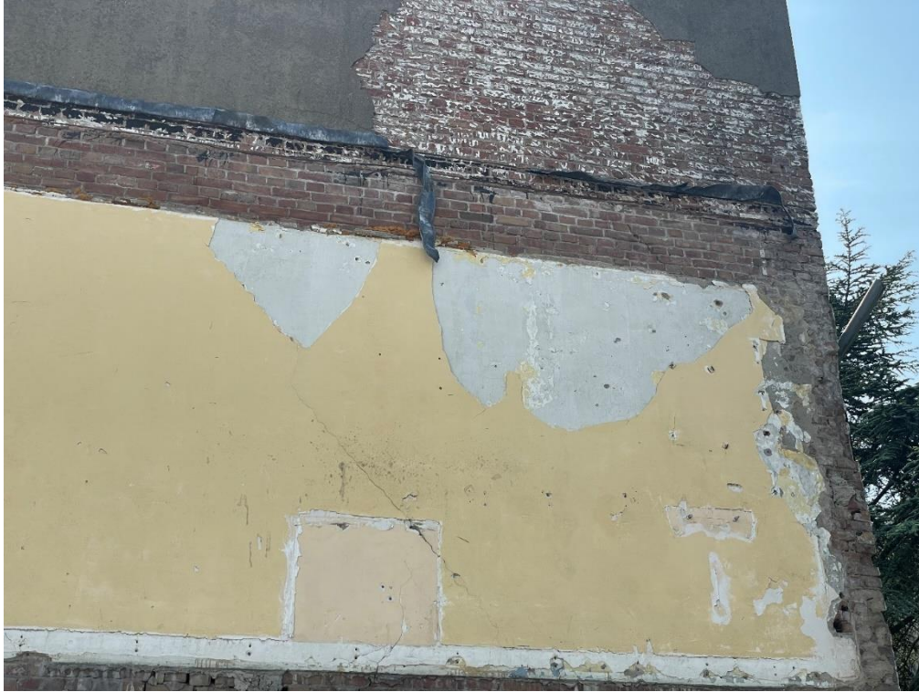
Lichte diagonale scheur boven gevelopening.
