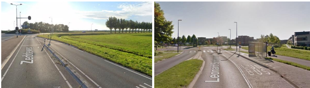
Figuur 1. Voorbeelden van een buspasseerstrook die voor de rotonde invoegt (links) en die op de rotonde aansluit (rechts) (Ctrl + Klik op de plaatjes om naar de situatie in GoogleMaps te gaan).
