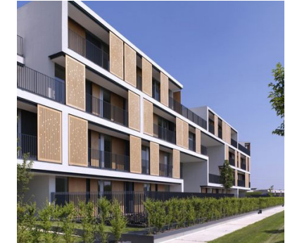
Dynamische gevels en horizontale banden benadrukken de horizontaliteit van gevel
