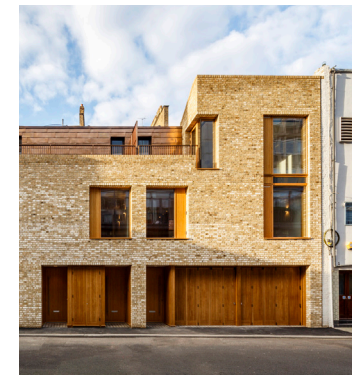
Gebruik van baksteen in de gevels met warme en natuurlijke kleuren
