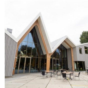
Het Dorpshuis heeft lichte bakstenen gevels aan de zijde van de kavel en houten gevels aan de andere kant.
