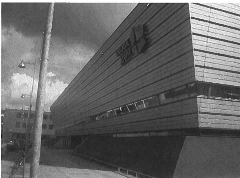
Arena 303, Sporthal Dudok Arena
