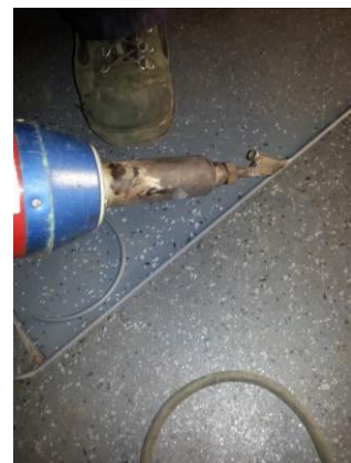
Lassen van deelnaden.
