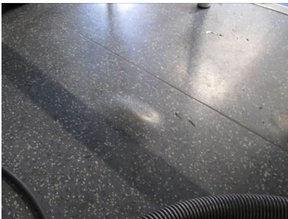
Luchtbel onder vloerbedekking.
