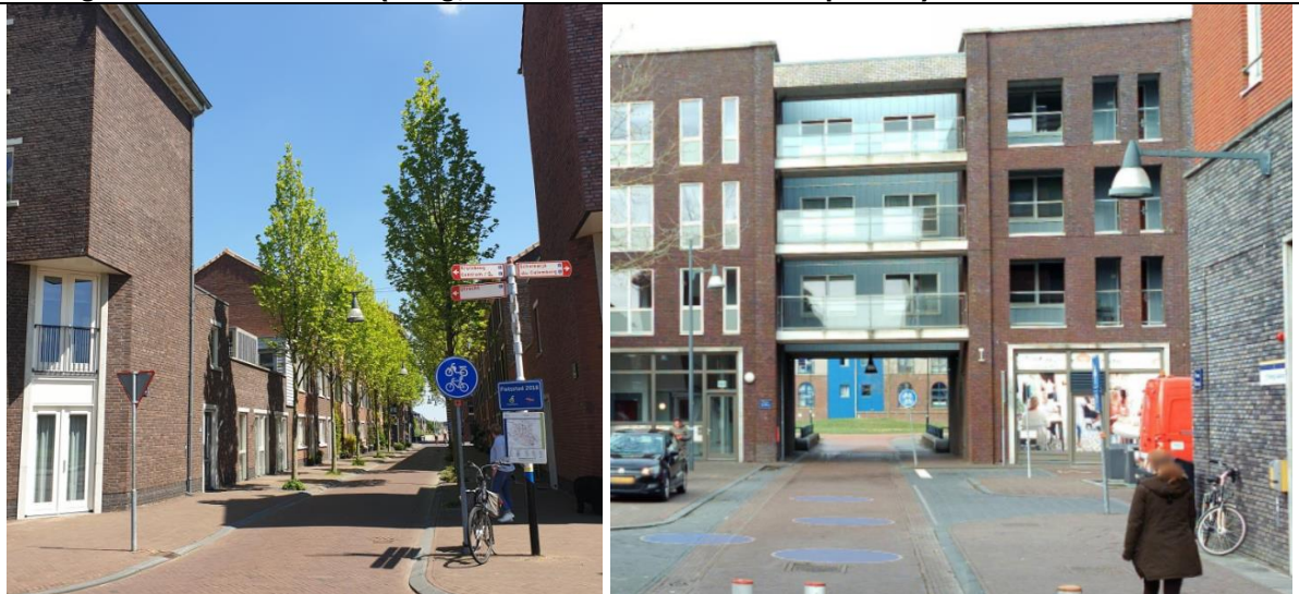
Huidige situatie Castellum (hang, wand en los staande lichtpunten)
