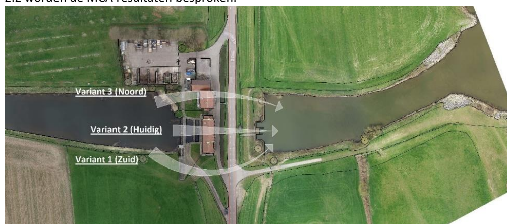
Figuur 1: Overzicht van gemaal Terwolde met daarin aangegeven de drie hoofdvarianten voor uitbreiding van de uitmaalcapaciteit
