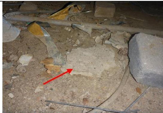
Restanten in kruipruimte onder TE0010/0024
