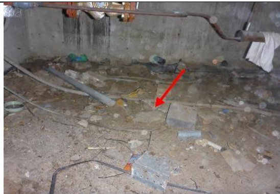
Restanten in kruipruimte onder TE0010/0024
