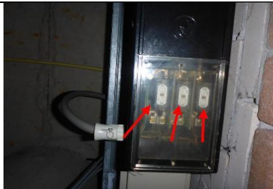
Meszekeringen in E-kast aan kabelgoot
