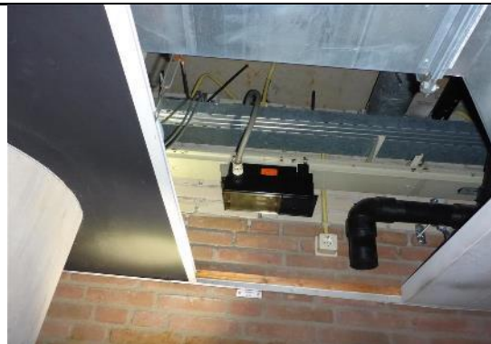
Meszekeringen in E-kast aan kabelgoot
