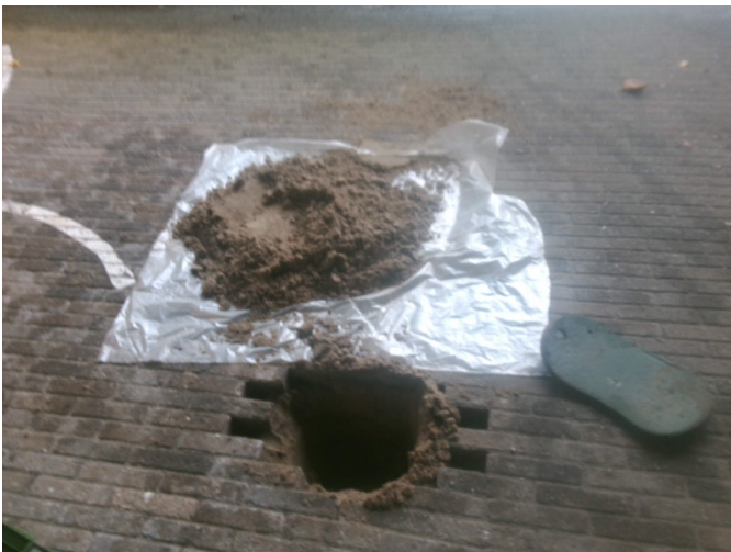
Foto 4: Asbestgat en boring (tot 0,5 m-mv) combi bij boornummer 11.
