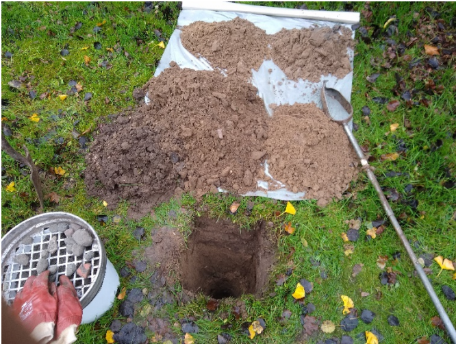
Foto 1: Asbestgat en boring (tot 2,0 m-mv) combi bij boornummer 2.
