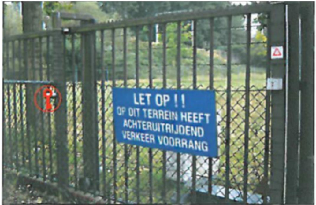
figuur 6-1 Sleutelkluis/-buis in het toegangshek
