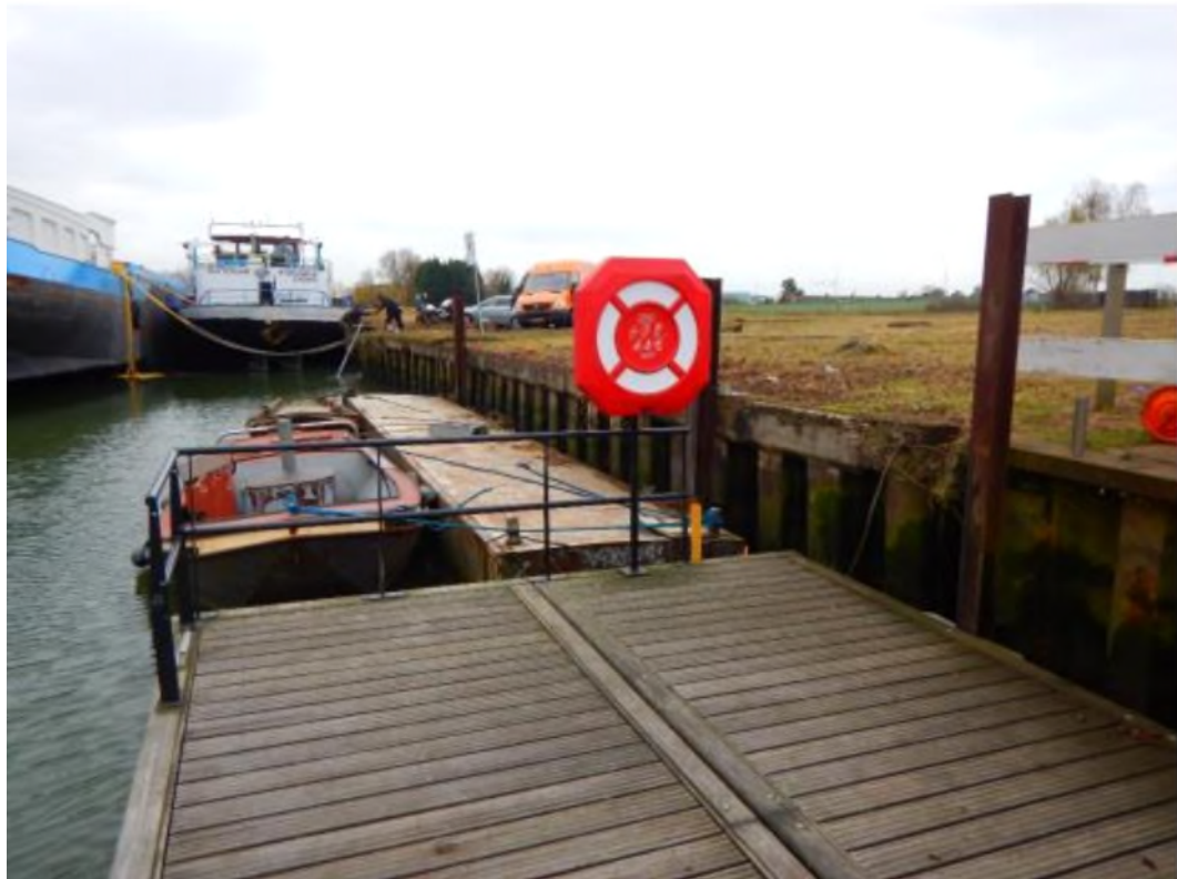
Figuur 1-1: Situatiefoto damwand Veersedijk 301 (Antea Group, 2016).
