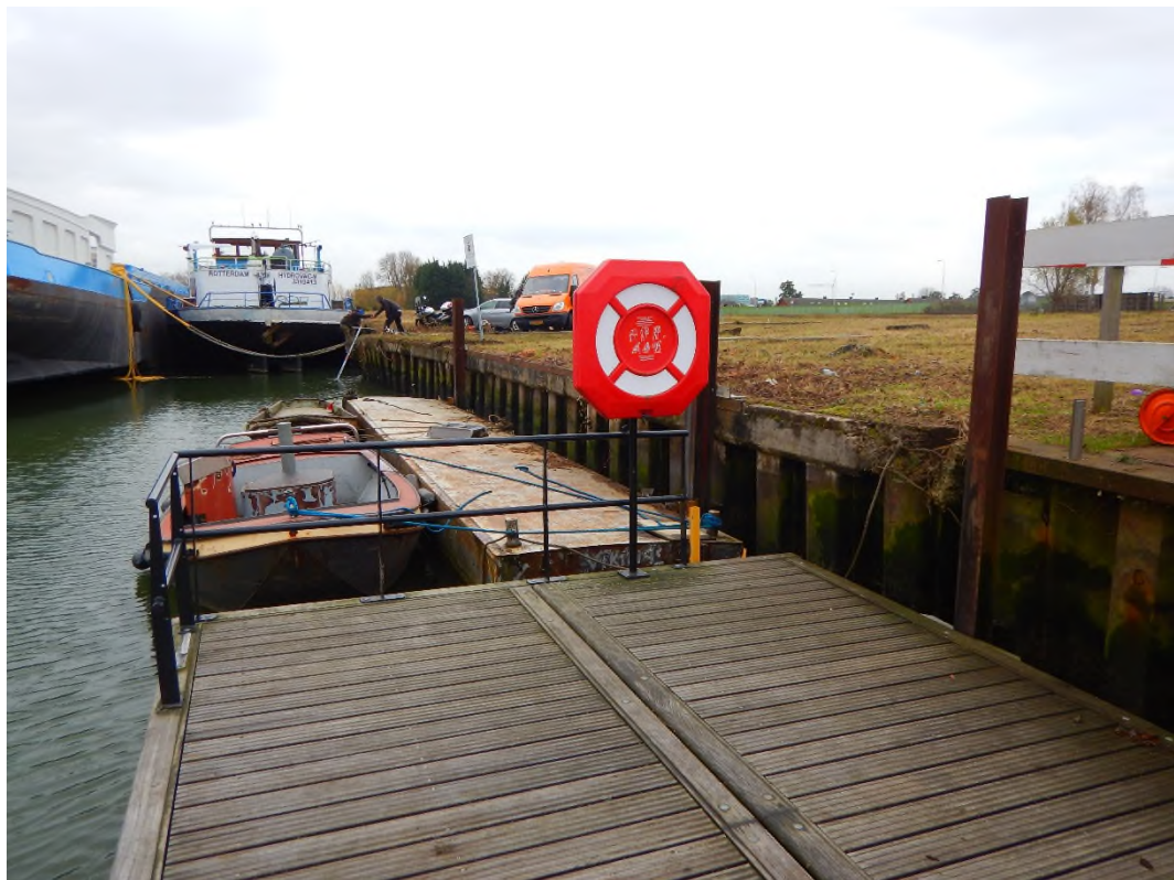
Foto 6 Constructietype 2, verankerde stalen damwandconstructie (U profiel).
