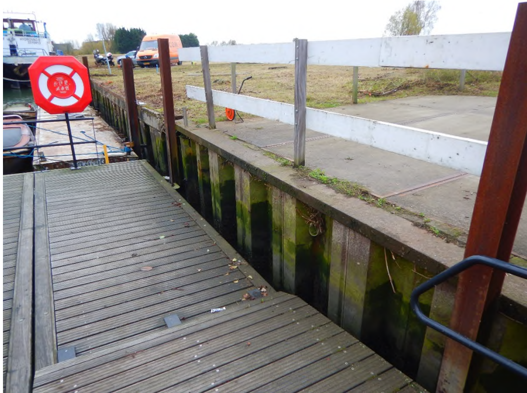
Foto 5 Constructietype 1, verankerde stalen damwandconstructie (Z profiel).
