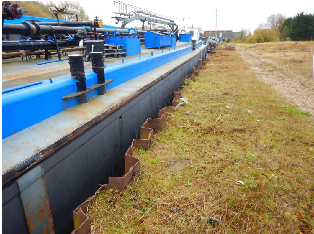
Foto 8: Constructietype 4, verankerde stalen damwandconstructie (Z profiel).
