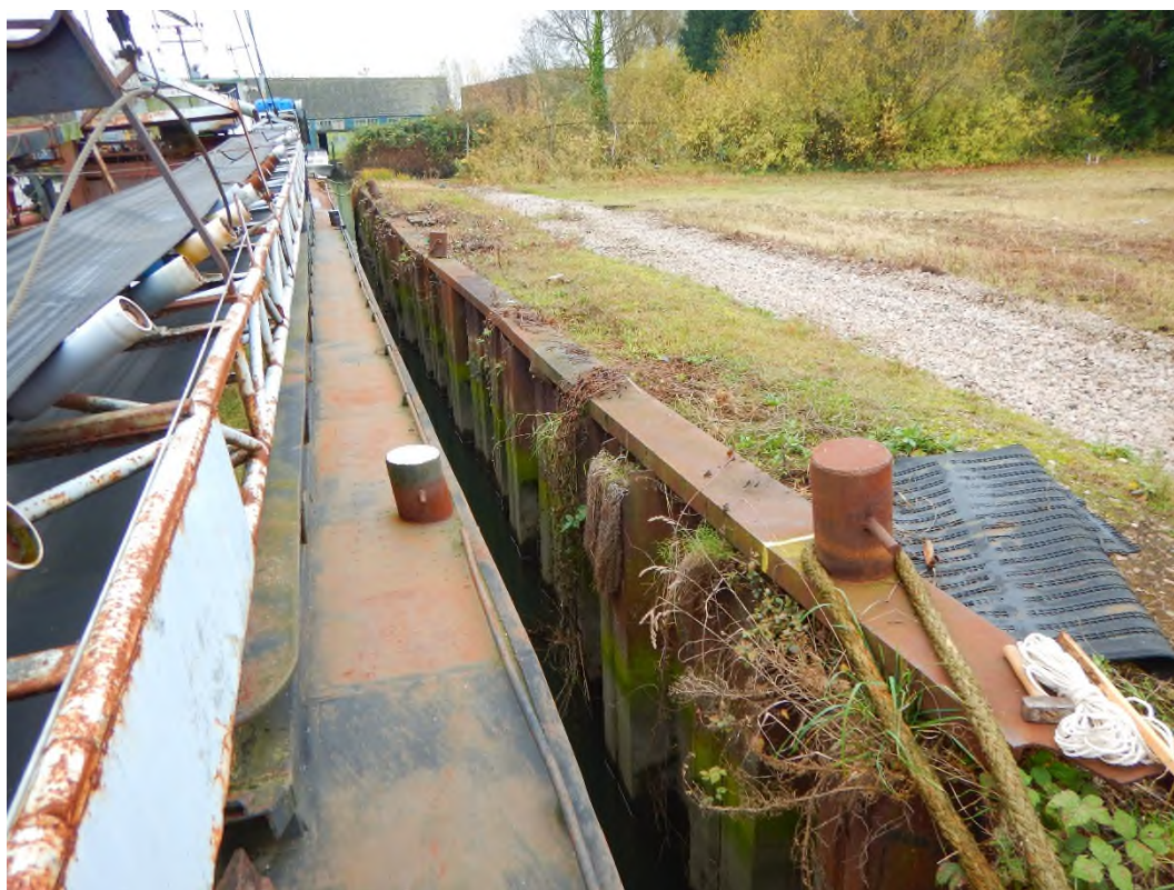
Foto 9: Constructietype 5, verankerde stalen damwandconstructie (Z profiel).
