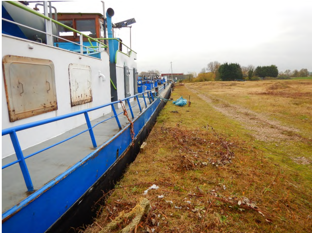
Foto 7: Constructietype 3, verankerde stalen damwandconstructie (Z profiel).
