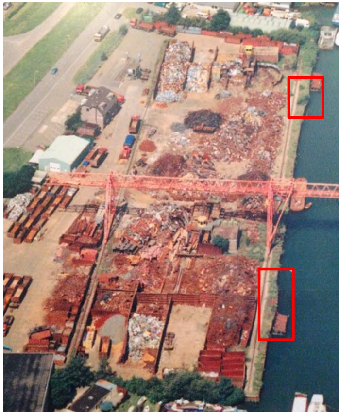
Foto 4: Aangeleverde overzichtsfoto terrein "Van Dalen" uit de jaren '90 waarbij de uitbuikende damwandconstructie ook reeds zichtbaar is.
