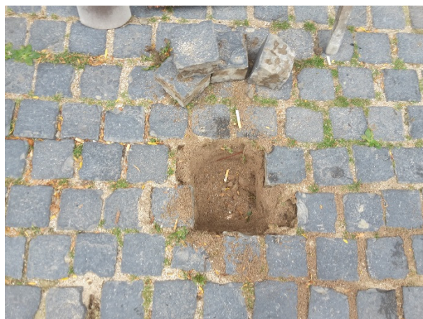
Foto 2: Proefgat 2 nabij boring 68
