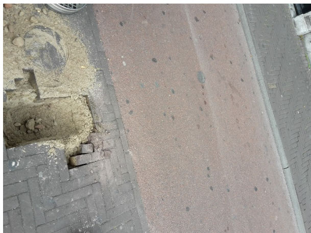
Foto 3: Proefgat 3 nabij boring 71
