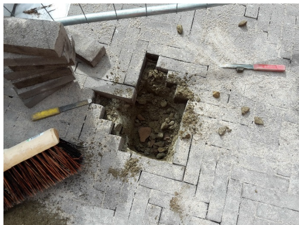
Foto 4 : Proefgat 4 nabij boring 59
