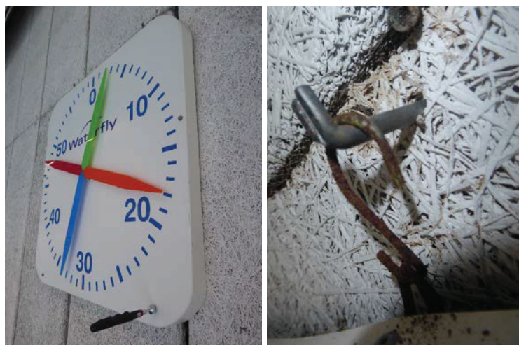
Foto 5.3 a) en b): Secondeklok bij het wedstrijdbad (links) en gecorrodeerde ophanghaak (rechts).
