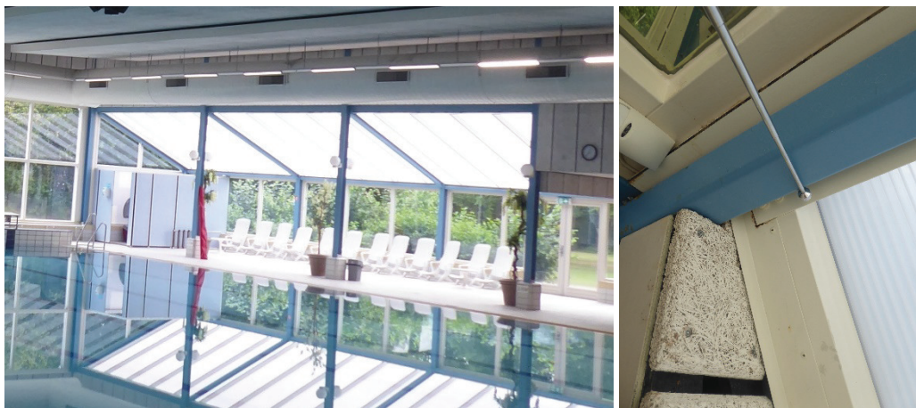
Foto 5.6 a) en b): Serre bij het wedstrijdbad (links) en kunststof bouwdelen van de serre (rechts).
