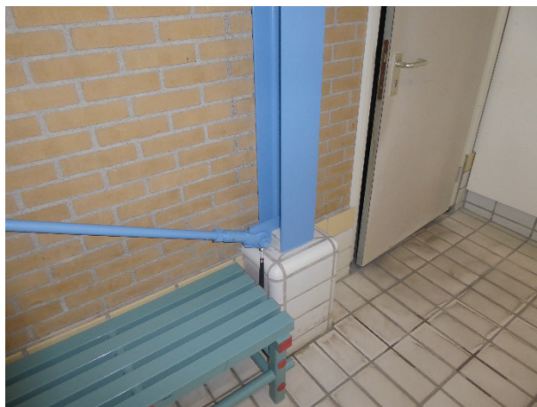
Foto 5.4 a) en b): Draagbalk en gording boven het wedstrijdbad (links) en kolom met windverband (rechts).
