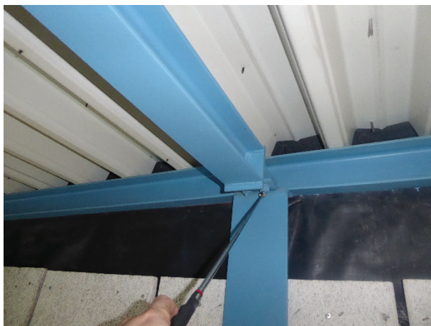
Foto 5.4 a) en b): Draagbalk en gording boven het wedstrijdbad (links) en kolom met windverband (rechts).
