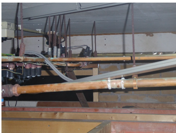
Foto 5.2: Gecorrodeerde ophangingen van (water)leidingen boven de douches
