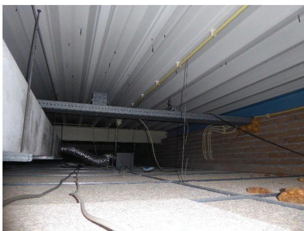
Foto 5.5: stalen draagconstructie boven het systeemplafond van de kleedkamers.
