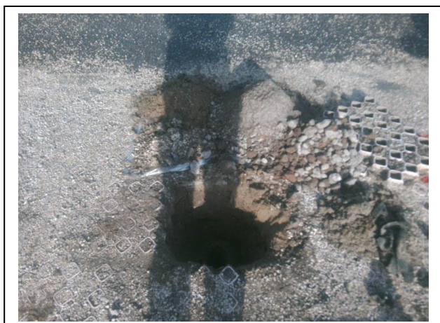
Foto 1. Opgegraven en gezeefd materiaal inspectiegat A01
