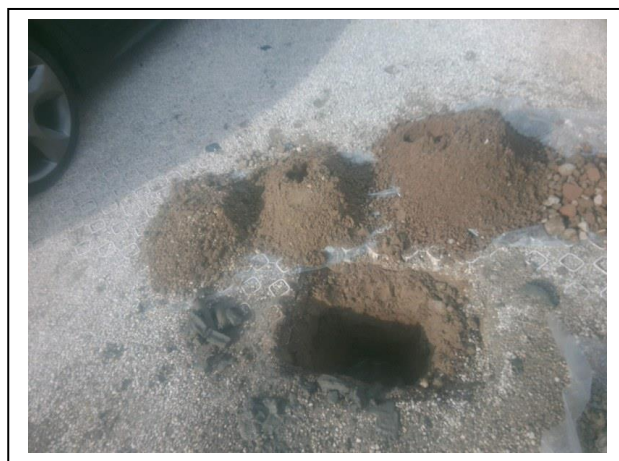
Foto 2. Opgegraven en gezeefd materiaal inspectiegat A03
