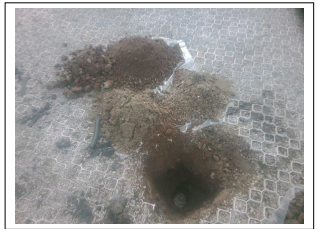
Foto 12. Opgegraven en gezeefd materiaal inspectiegat A13
