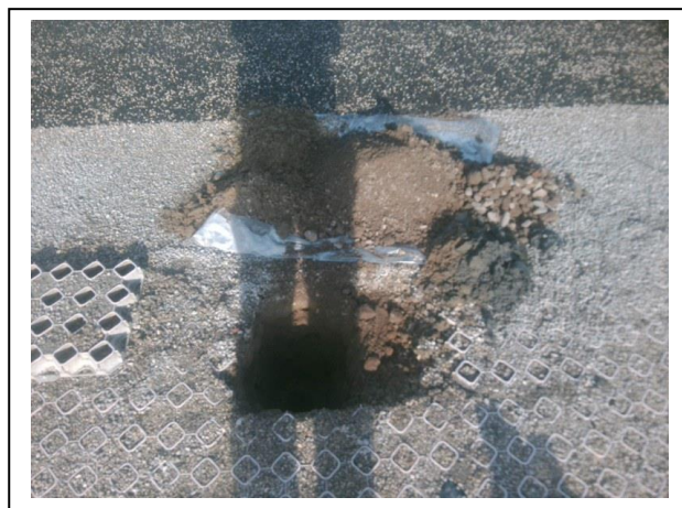
Foto 4. Opgegraven en gezeefd materiaal inspectiegat A05
