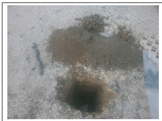
Foto 6. Opgegraven en gezeefd materiaal inspectiegat A07
