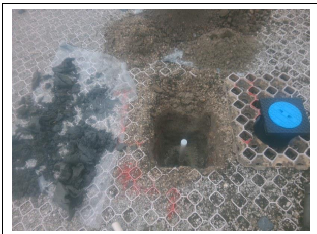
Foto 9. Opgegraven en gezeefd materiaal inspectiegat A10
