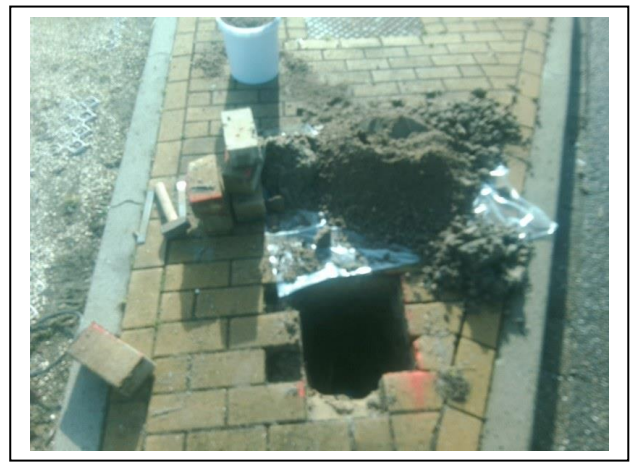
Foto 10. Opgegraven en gezeefd materiaal inspectiegat A11
