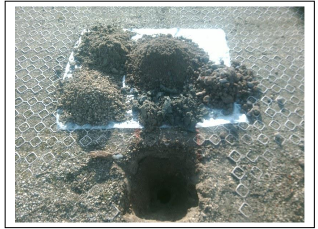
Foto 14. Opgegraven en gezeefd materiaal inspectiegat A15
