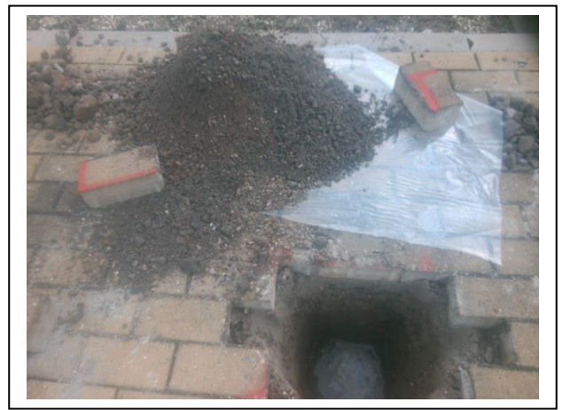
Foto 16. Opgegraven en gezeefd materiaal inspectiegat A17
