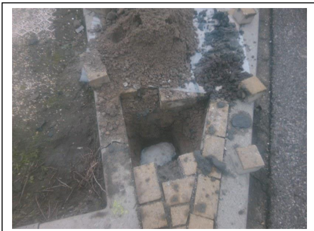
Foto 11. Opgegraven en gezeefd materiaal inspectiegat A12
