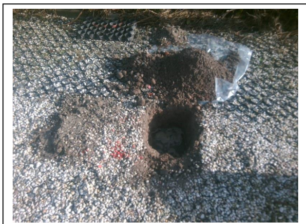
Foto 3. Opgegraven en gezeefd materiaal inspectiegat A04
