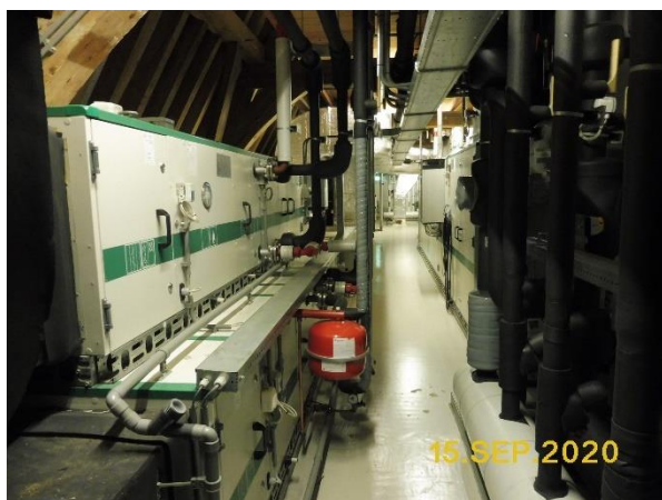
Omvangrijke technische ruimte op de zolder van het Zeeuws Museum.
