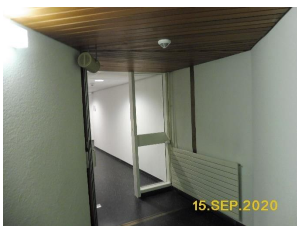
Inkijk in de verbindingstunnel tussen de gebouwen 3 en 4.
