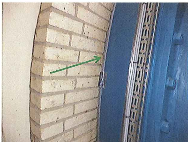
Foto 1. Niet-asbesthoudende kit pompen begane grond gemaal (mm1)
