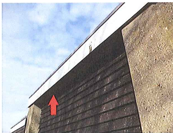
Foto 10. Asbesthoudende vlakke plaat overstek boei schotbalkenloods (mm8)
