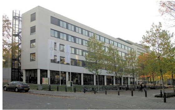
Building D (Dante)
