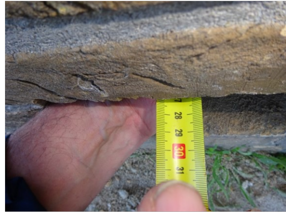
Foto 8 - Diepte meting tot binnenblad
