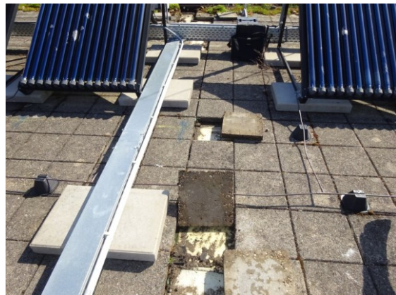
Foto 46 - Controlemetingen dikte isolatie
