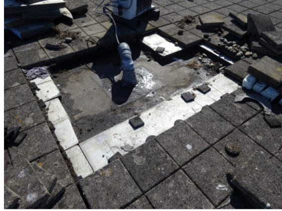
Foto 32 - Plaatselijk zijn er herstelwerkzaamheden aan dak doorvoeren uitgevoerd en/of zijn doorvoeren bijgeplaatst
