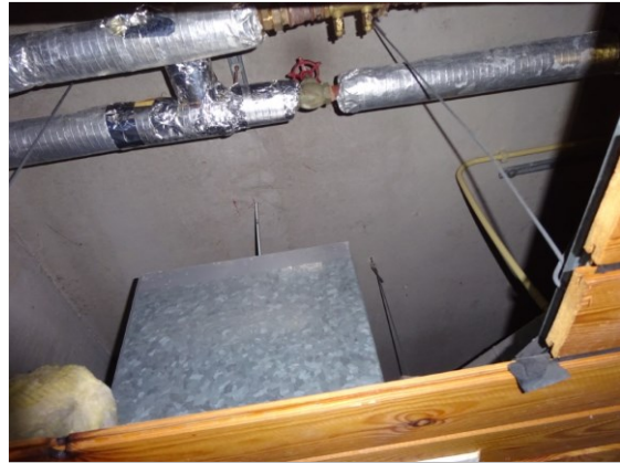
Foto 56 - Onderzijde betonnen dakvloer kantoren
