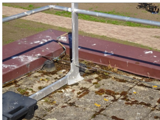
Foto 48 - Controlemeting afschot bij kopgevel
