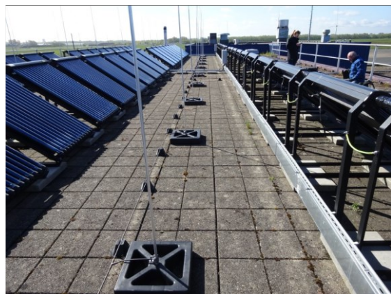
Foto 18 - Overzicht bliksembeveiligingsvoorzieningen
