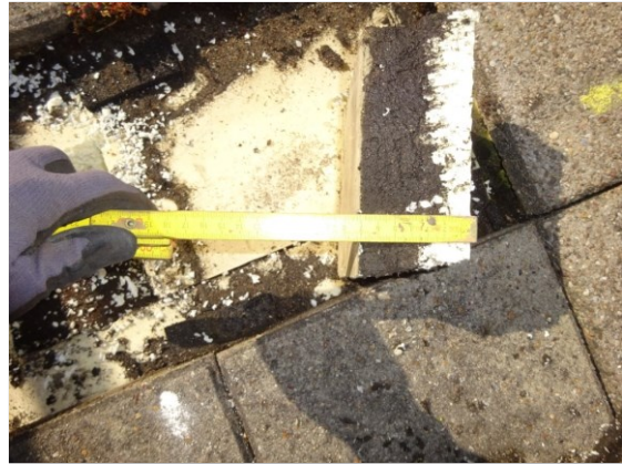
Foto 44 - Meting XPS isolatie 70 mm
