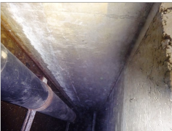
Foto 59 - De kruipruimte heeft geen verbinding met kantoor (geen kruipluik/ruimte)
