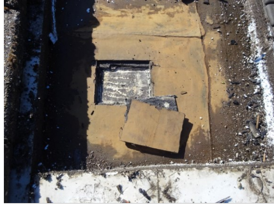
Foto 20 - Detailopname insnijding dakbedekking
