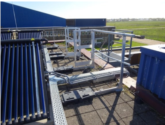
Foto 27 - Dakopgang via vaste trap
