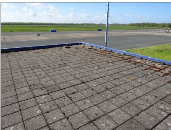
Foto 41 - Overzichtsfoto overige daken
