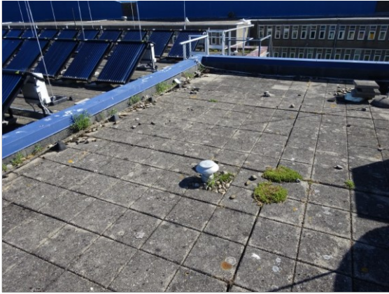
Foto 31 - Overzicht naast gelegen hoger dak
