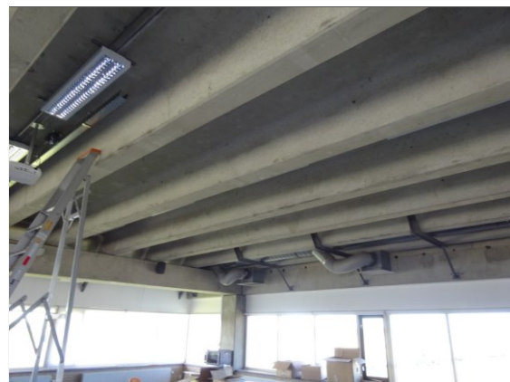
Foto 54 - Onderzijde onderconstructie restaurant dak
