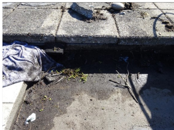
Foto 36 - In de door zon belaste dakbedekkingsdelen treedt craquelé op (verouderingsscheurtjes)
