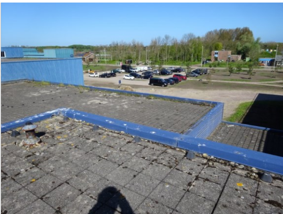
Foto 39 - Overzichtsfoto overige daken
