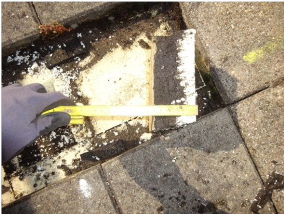
Foto 43 - Meting XPS isolatie 70 mm
