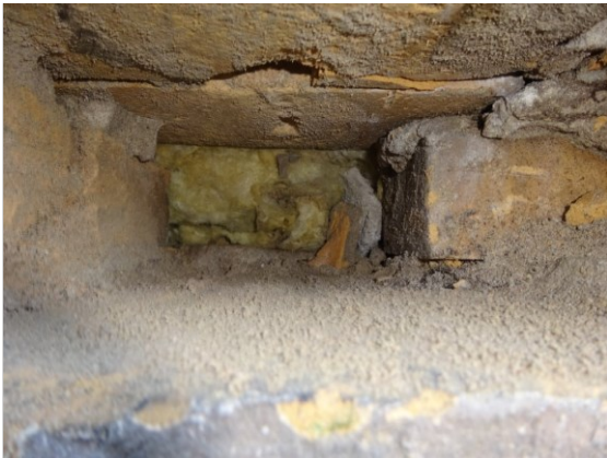
Foto 7 - In de spouw is 75 mm steenwol aanwezig (volledige spouwvulling)
