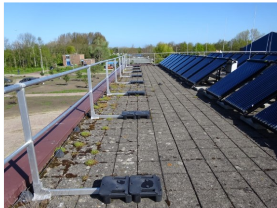
Foto 16 - Overzichtsfoto dakrand dak
