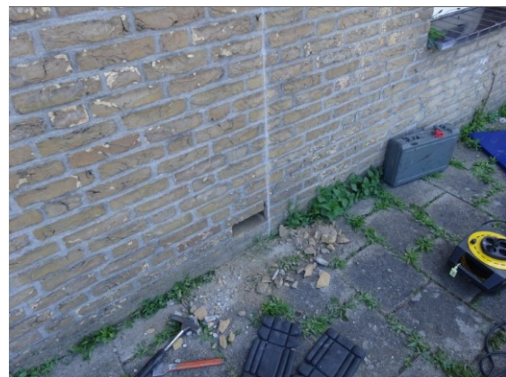
Foto 6 - Locatievaststelling samenstelling spouwmuurconstructie
