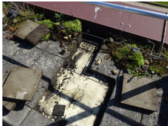
Foto 22 - Isolatie langs zijde voorgevel tot aan noklijn 70 mm XPS
