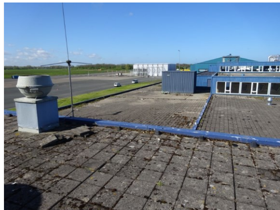
Foto 40 - Overzichtsfoto overige daken
