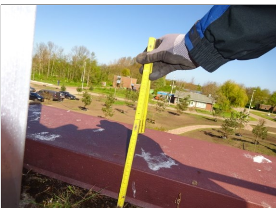
Foto 47 - Controlemeting hoogte afschot bij kopgevel
