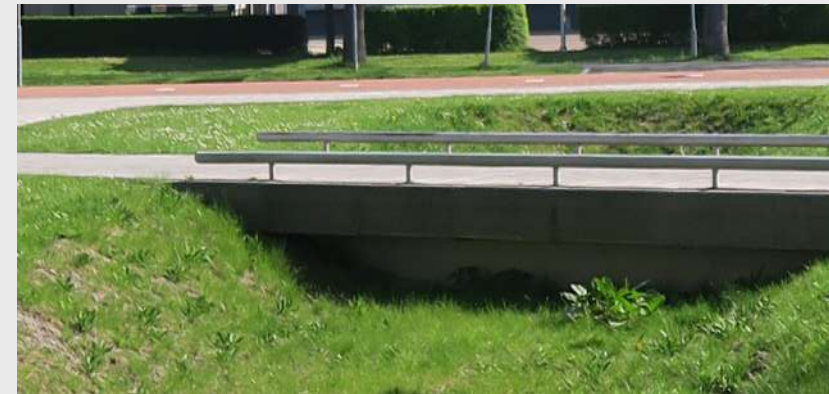
Toegang tot kamer
