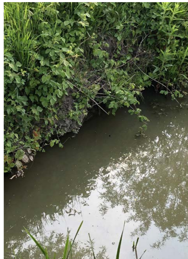
Veel oevers hebben onderhoud nodig omdat ze afkalven wegens een vast waterpeil
