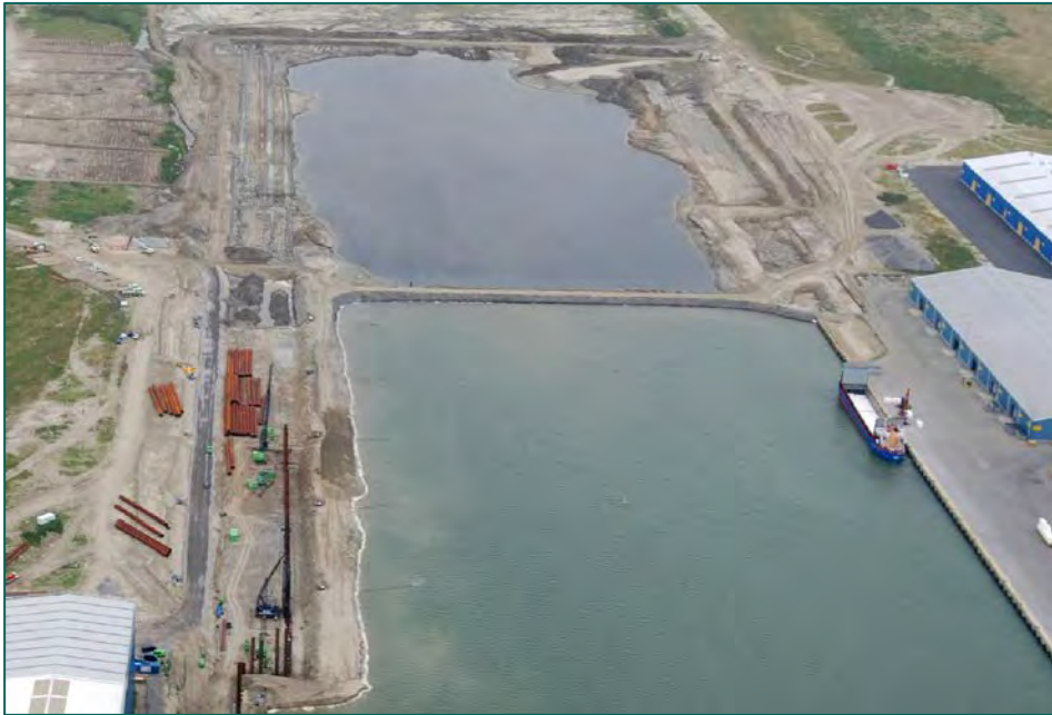
Figuur 29: 2e fase aanleg Scaldiahaven.
