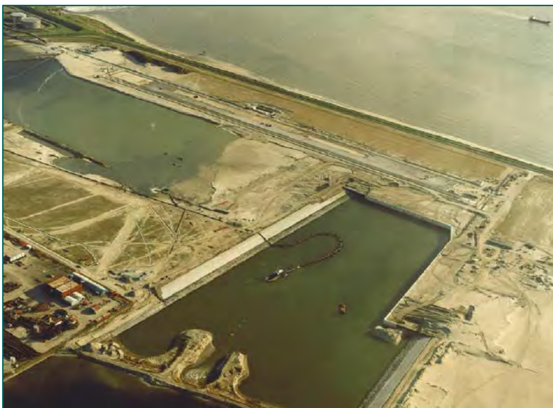
Figuur 17: Beeld aanleg Kaloothaven.
