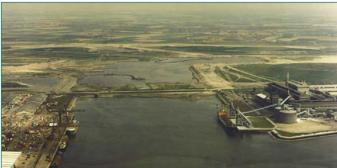
Figuur 21: Aanleg Quarleshaven.
