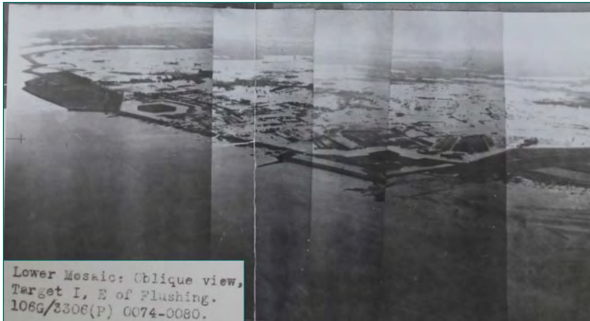
Figuur 28: Luchtfoto van de zeedijk bij Fort Rammekens (Bron: NARA, RG 243, box 54).
