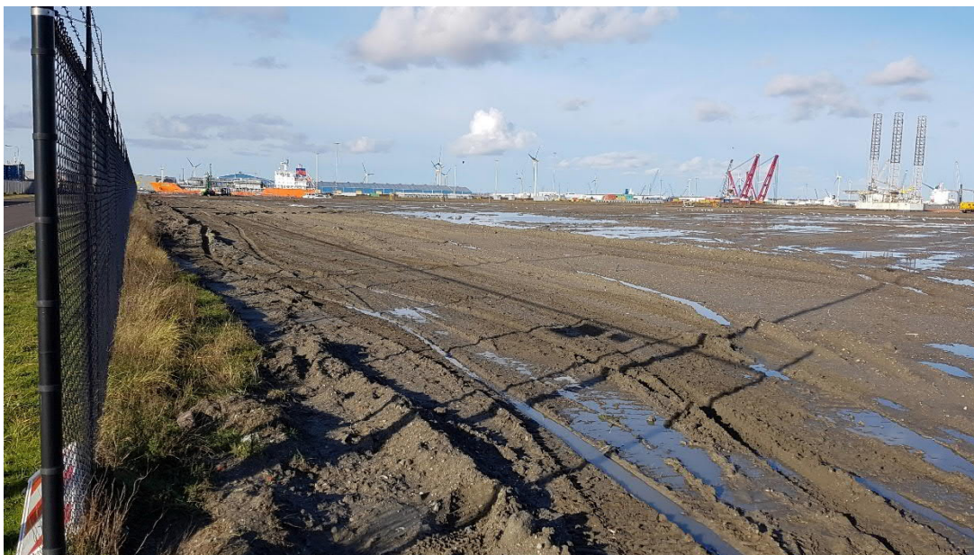
3.1 Impressie actuele situatie te plaatse
