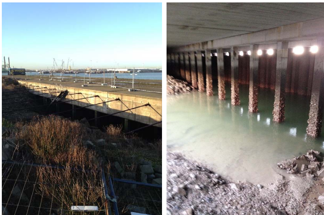
Figuur 1-2: Verzakking achter kade (03-02-2014)
