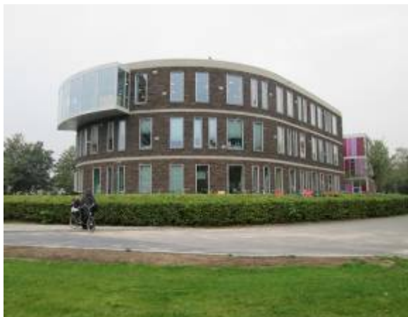
foto 3: Zijgevel – achterkant schoolgebouw.
