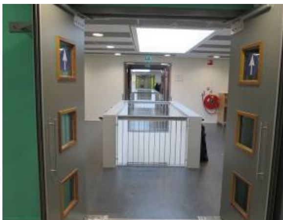
foto 5: Etage met compartimentdeuren.
