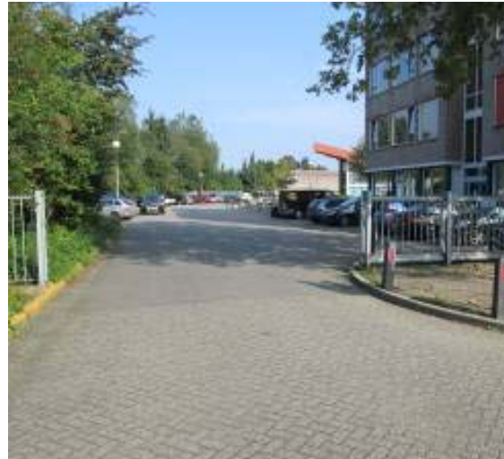
foto 2: Toegang achterterrein met hekwerk.
