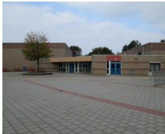
foto 8: Vrijstaande dubbele gymzaal.
