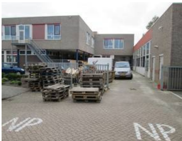
foto 5: Achterbouw met buiten opslag pallets.
