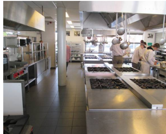
foto 8: Technieklokaal, consumptief (keuken)
