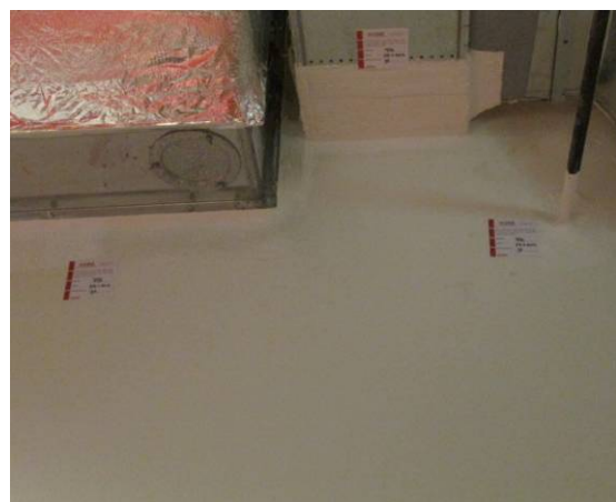
foto 12: Doorvoeren afgedicht.
