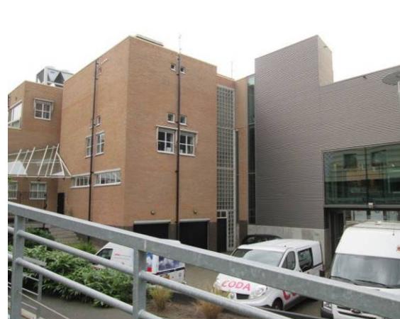
foto 4: Belending bibliotheek (metselwerk).
