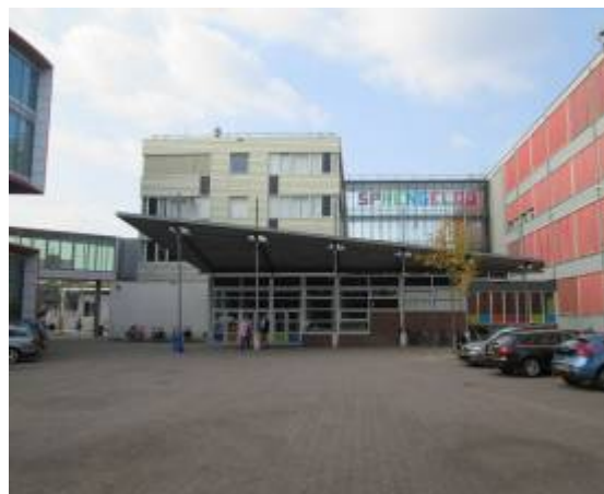
foto 2: Voorgevel, rechts bestaande bouw.
