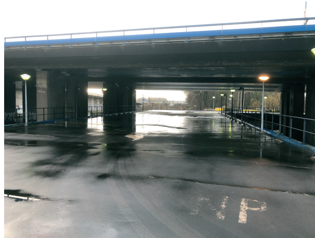
Foto's dek parkeergarage
