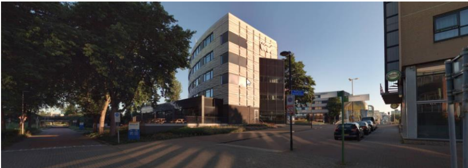
Looproute P+R Rokkeveen (Zuidzijde): links bevindt zich de P+R en rechts het Plein van de Verenigde Naties (opgang Nelson Mandelabrug)
