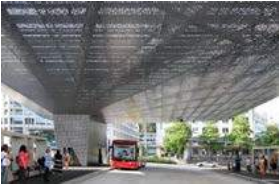
busstation met transparante lichtdoorlatende overkapping, Winterthur
