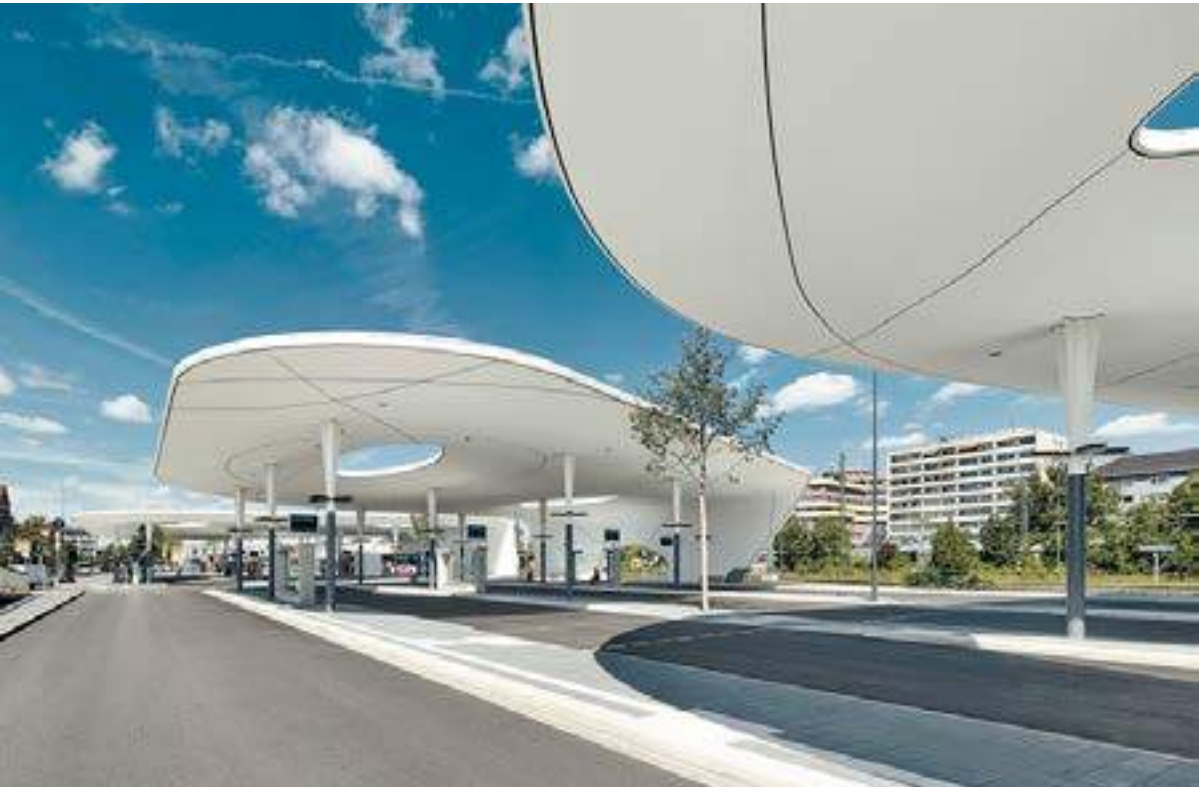
licht kleurgebruik, busstation met overkapping, Pforzheim
