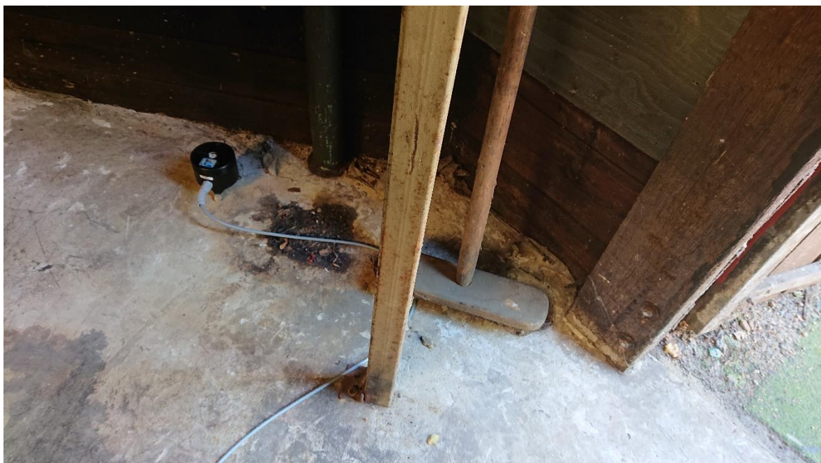
Figuur I.8. Meetpositie 17. De meeste sensoren zijn op een dergelijke (kleine) betonnen vloer geplaatst
